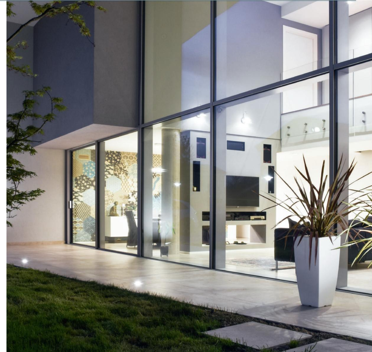
Nuovo design esclusivo ed elegante per una facciata completamente trasparente, senza compromessi: la facciata Schüco FWS 35 PD offre una soluzione integrata nel sistema, che consente di ottenere angoli interamente in vetro senza profili di montanti verticali.
